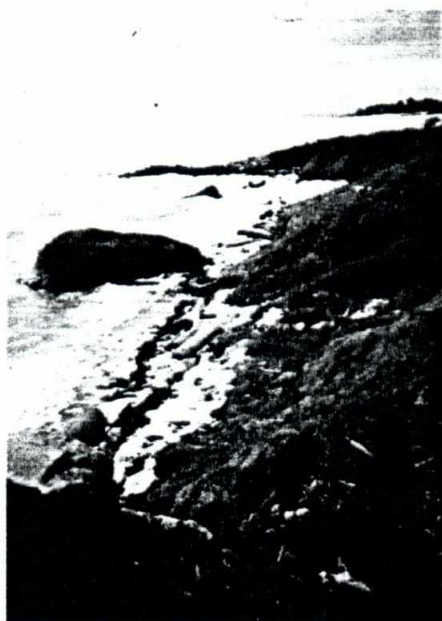
Foto 4. En primer plano se observan los sacos de arena y piedra que son colocados para resistir el oleaje. Con el tiempo también son destruidos.
