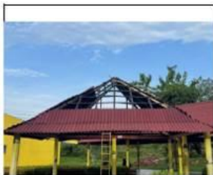
DURANTE CAMBIO DE CUBIERTA DE PALMA
